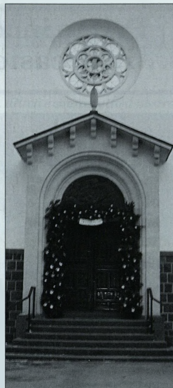
L'ingresso della chiesa.
