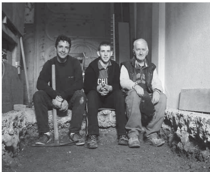
Finalmente completato lo scavo di fondazione
