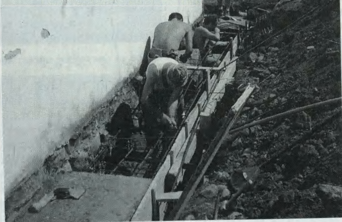
Un angolo della Chiesa della Madonna della Salute durante i lavori di risanamento e di allargamento delle fondazioni.
