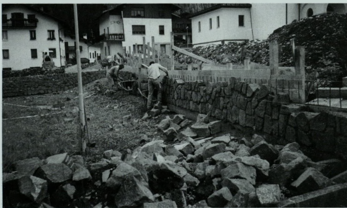
Claudio e Lino alle prese con il muretto, mentre Fabio prepara gli scavi necessari. I lavori vengono eseguiti dalla ditta Marmolada.
