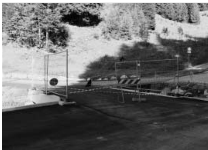
Il ponte nuovo a Colmean.
