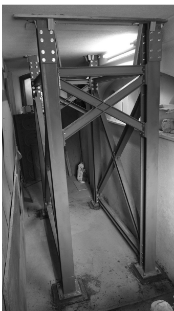
La struttura portante in cripta
