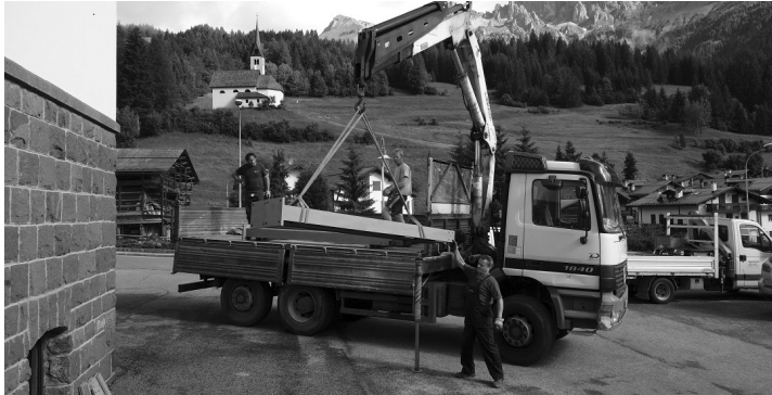
Lo scarico delle colonne portanti in acciaio
